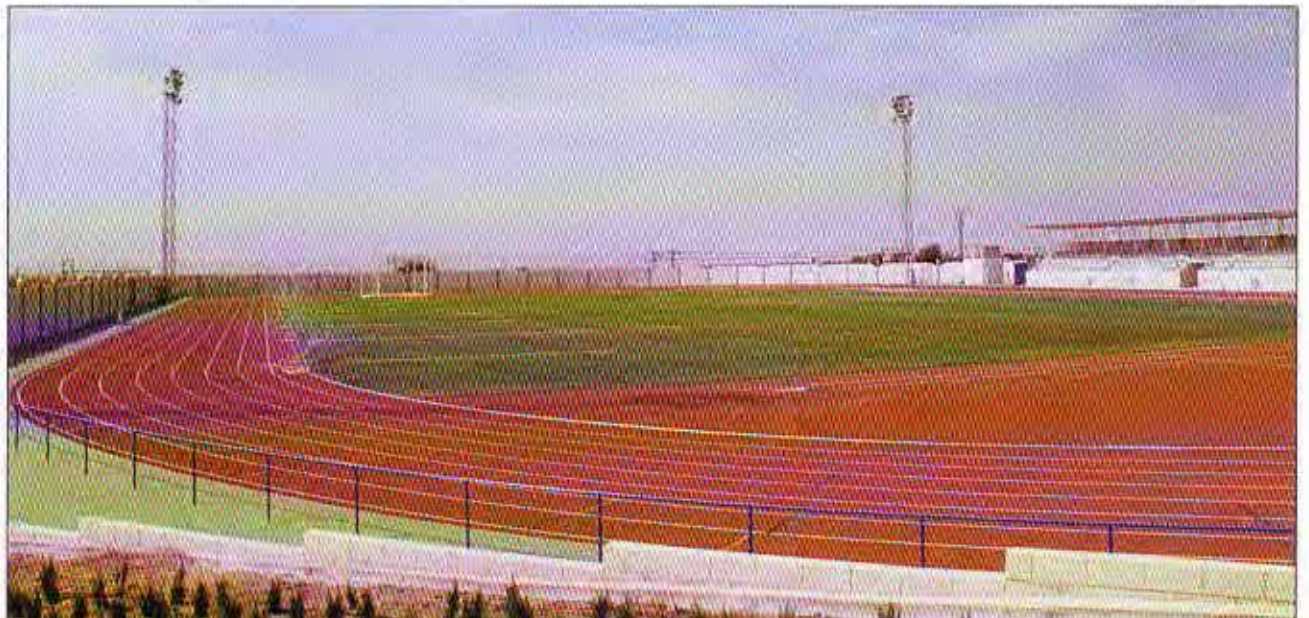
Panorámica de la nueva pista de atletismo
