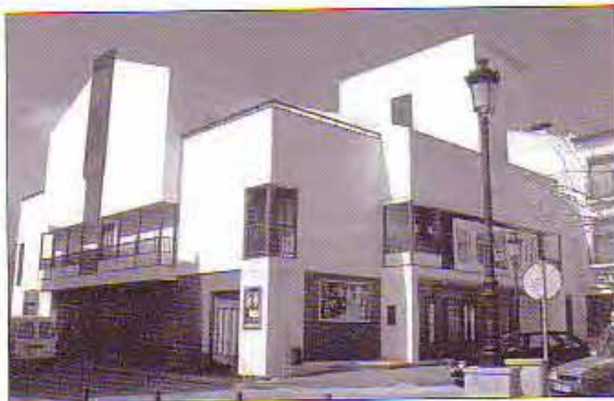
Teatro Cervantes, edificado donde estuvo el Hospital de San Bartolomé
